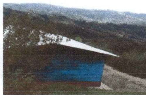
Foto 4: Sustitución de lámina, por lámina troquelada de aluzinc calibre 26, modulo 3.
