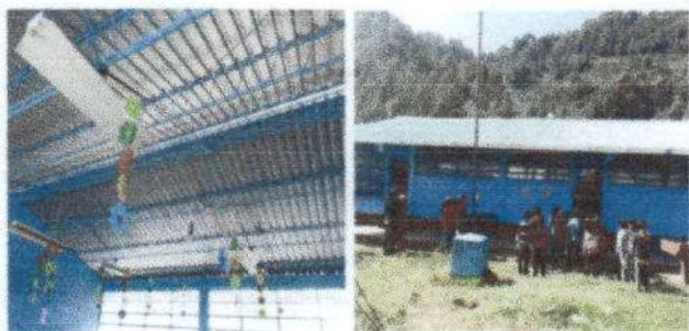
Foto1: Sustitución de lámina, por lámina troquelada de aluzinc calibre 26 módulos 1,2,3,4 y 5
