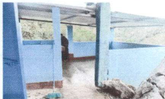
Foto 2: Mantenimiento a estructura de soporte metal.
