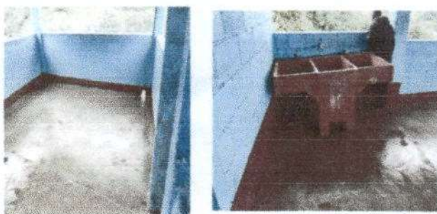
Foto 3: Reparación de piso de torta de concreto y pila de tres lavaderos.
